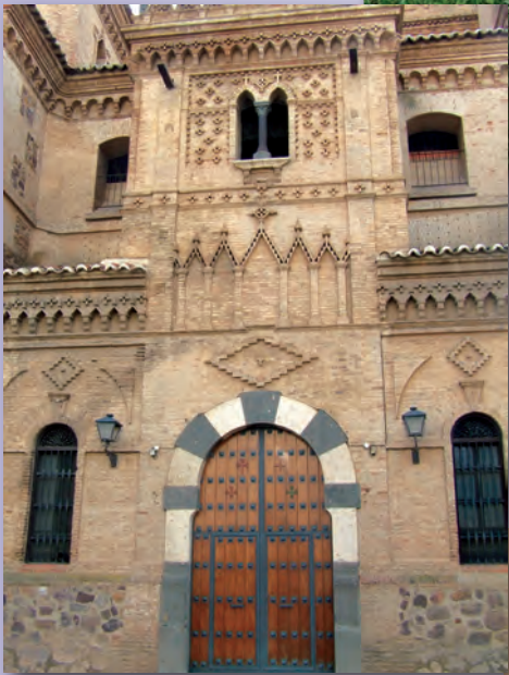
Ermita de la Virgen de la Soledad (Moral de Calatrava). La portada se resuelve en un arco que intercala bloques de basalto con caliza, siguiendo un modelo profusamente utilizado en la ciudad siciliana de Catania.
