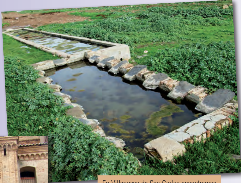
En Villanueva de San Carlos encontramos, a la salida del municipio, abrevaderos y lavaderos en los que las lajas de las pilas son de basalto.
