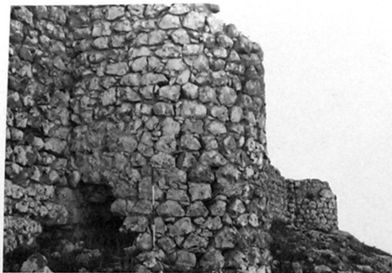
Cerramiento oeste. Obsérvese, en el desplome, que los torreones se construyeron después del muro, adosados a éste. (Eslava Galán, 1979).
