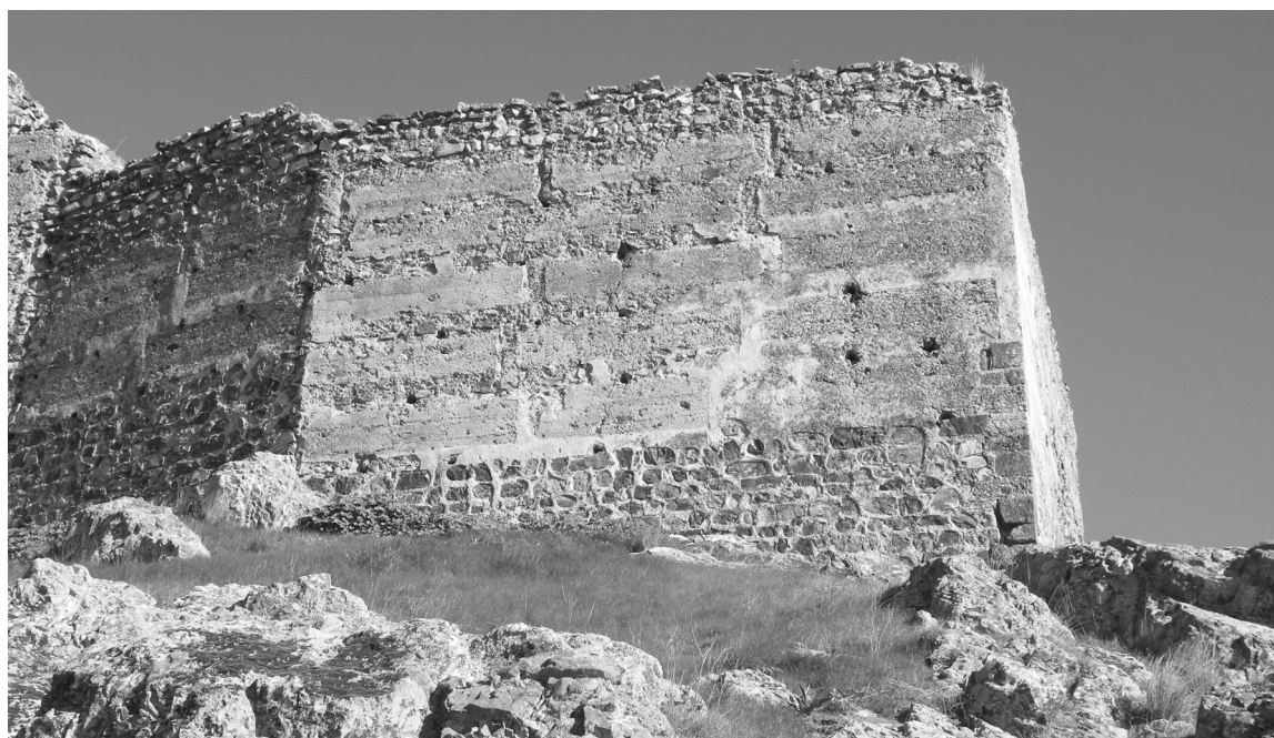
Fig. 6. Frente sur del castillo, donde se ha conservado perfectamente tanto el llagueado del zócalo de mampostería como el falso despiece de sillería.
