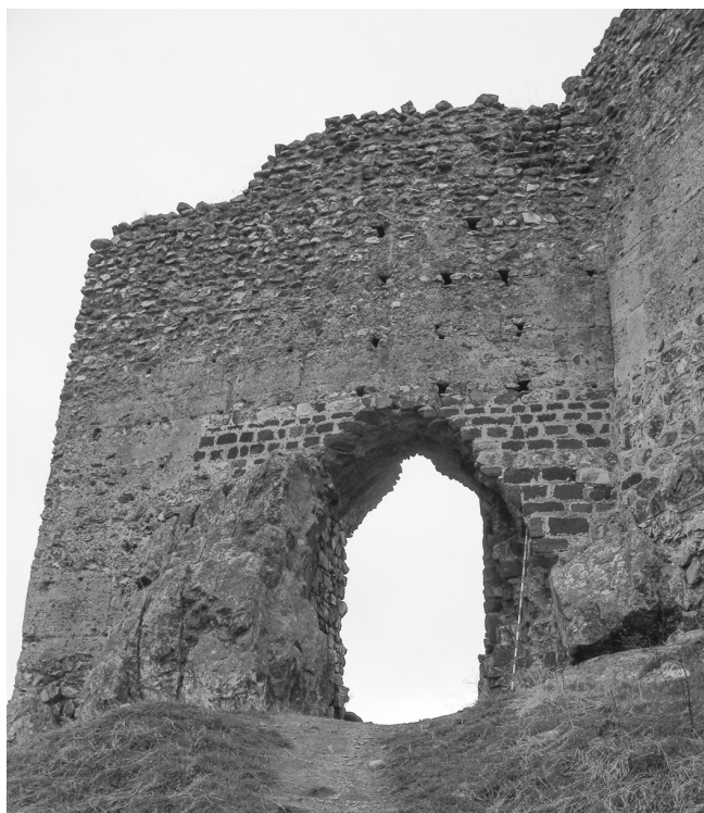
Fig. 8. Puerta de acceso al castillo con enmarque de sillaría.
