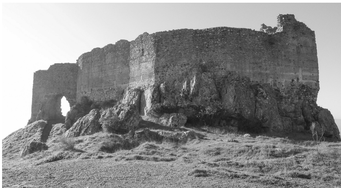
Fig. 3. Vista general del castillo de Miraflores desde el norte.
