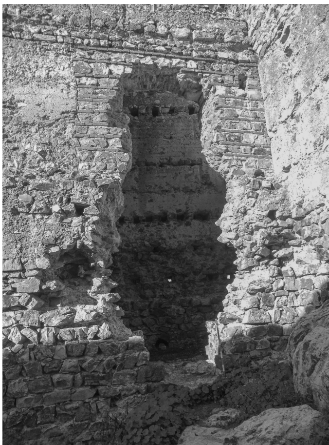
Fig. 9. Mampostería encintada Tipo A en el acceso interno al primer piso de la torre.
