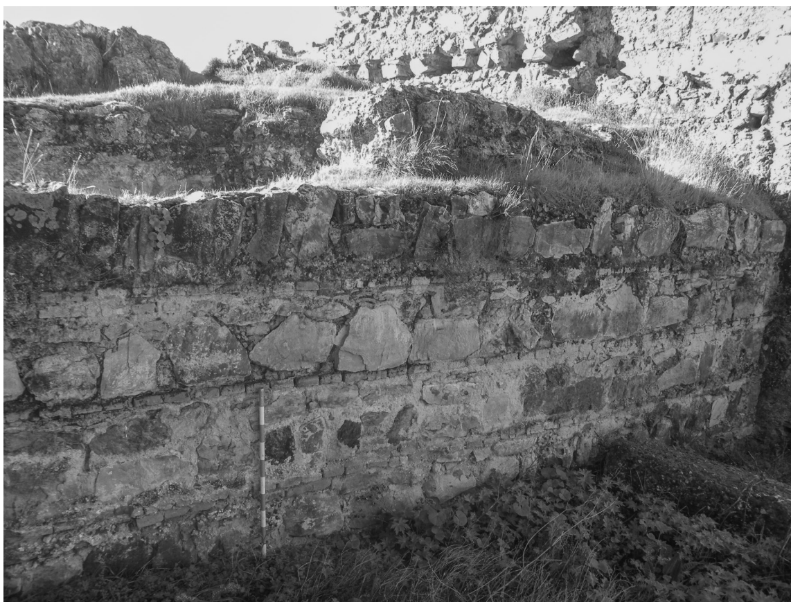
Fig. 10. Interior del aljibe. Mampostería encintada tipo B.
