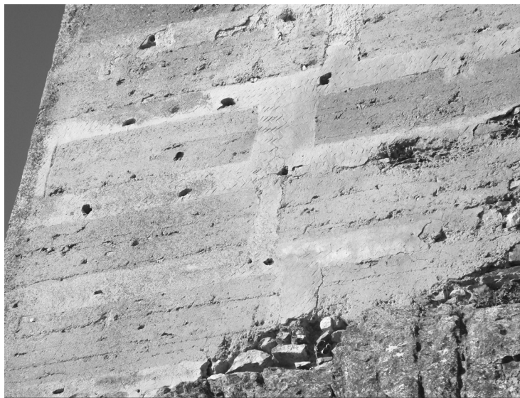
Fig. 7. Decoración incisa en el encintado de los cajones de tapial.
